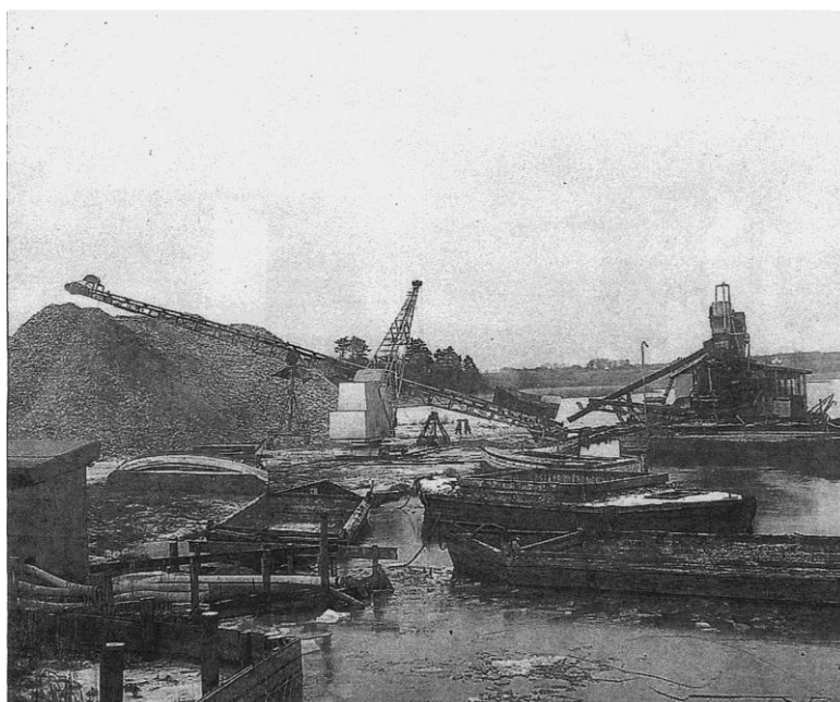
ØTA-Kompagniet anvendte i 1950'erne og 1960'erne pramme og gravemaskiner til opgravning af østersskaller i Stensballesund. Fotografiet er venligst udlånt af Byarkivet.
