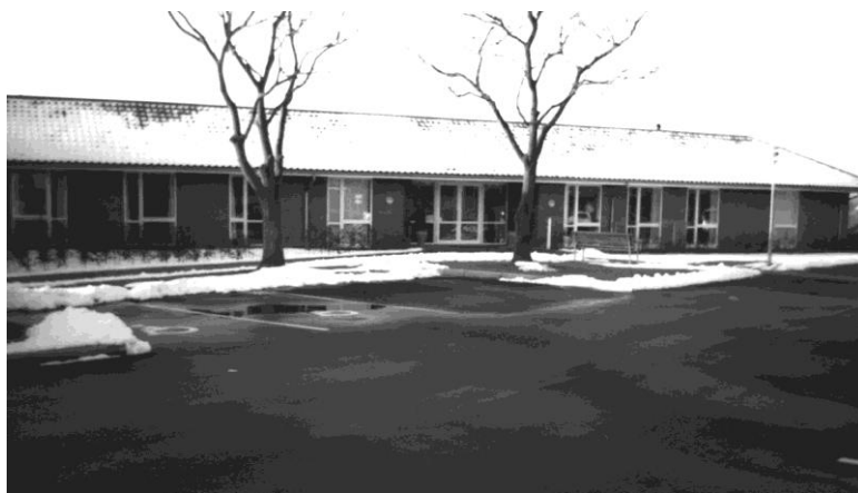
Indgangspartiet til Nørrevang, set fra nord. Foto 2006.
