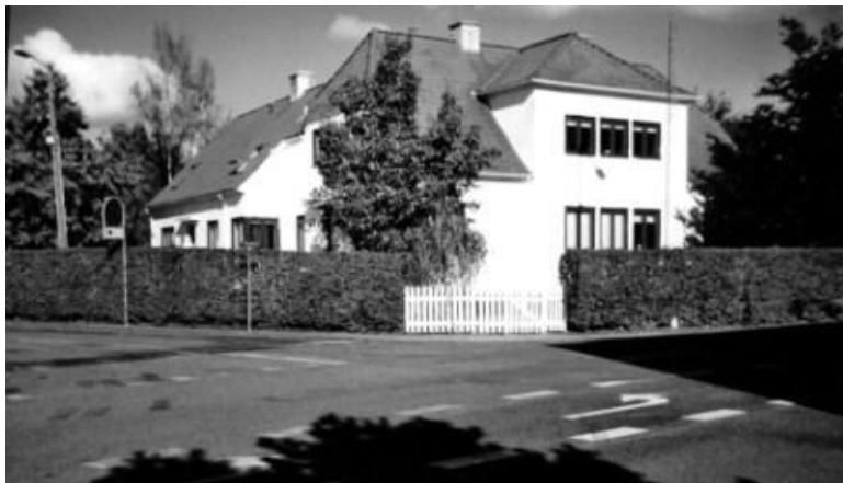
Hjørnevillaen på Bygaden 77, 2004.
